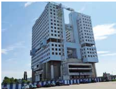
Das Rätehaus wird abgerissen
