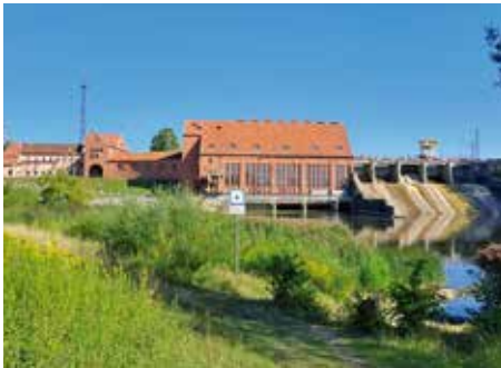
Das deutsche Wasserkraftwerk in Friedland arbeitet seit 1924 mit wenigen Unterbrechungen immer noch zuverlässig.
