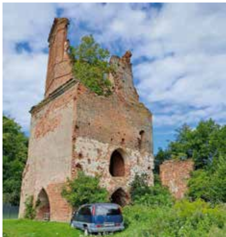
Die Kirche in Kreuzburg ist nur noch Ruine
