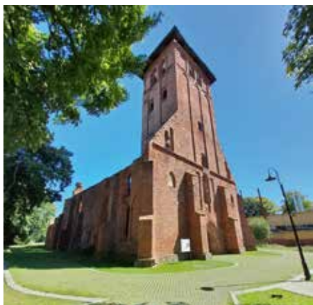
Die Kirche in Wehlau ist sehr gepflegt
